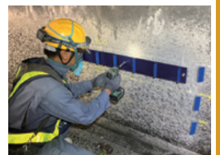
視線誘導ライン試験施工状況 (長野自動車道 (特定更新)岡谷トンネル覆工補強工事)
