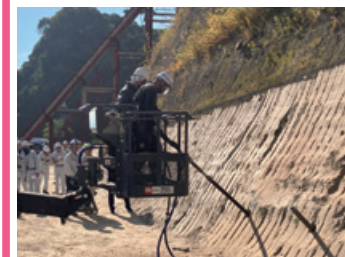
ホーク・ネーリングの試験施工状況
