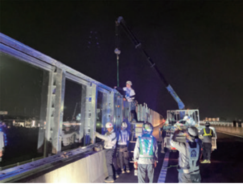
首都圏中央連絡自動車道 幸手西遮音壁工事 施工状況
