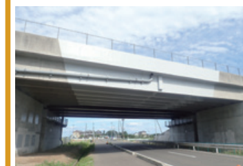
仙台東部道路 館腰橋補修工事
