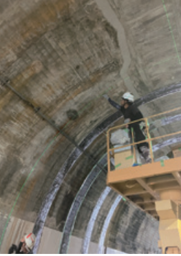
ガイナSHシートボード工法施工状況
