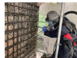
令和4年度 中国自動車道(特定更新等) 千代田高速道路事務所管内構造物補修工事 (ウォータージェットはつり施工状況)
