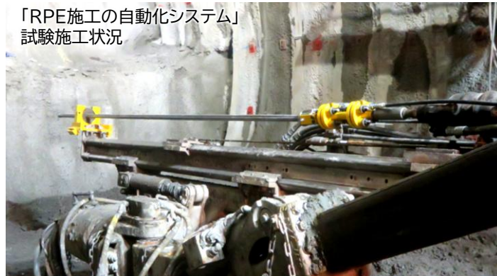
「ロックボルト自動打設用TD24 繋ぎボルト」
