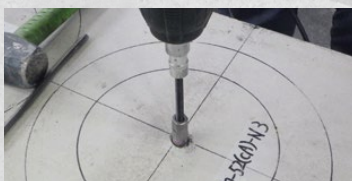
STEP4 反力ホルダ回転挿入
