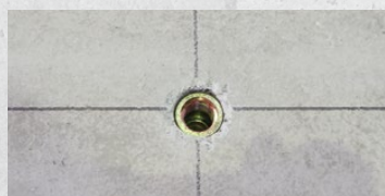
STEP1 取付物の撤去
