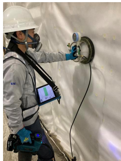
補修箇所負圧検査(バキュームチェック)
