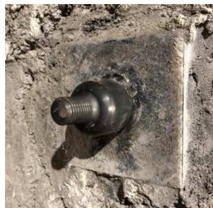
(引抜試験用治具の設置状況)
