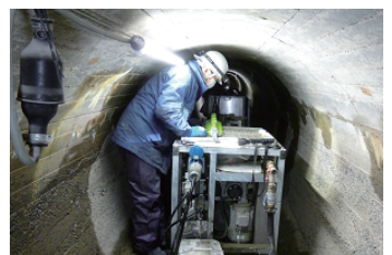
水路トンネル
