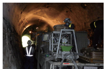
鉄道トンネル
