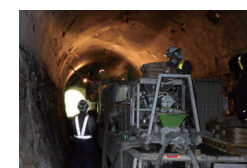
鉄道トンネル
