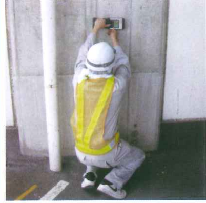
鉄筋検査状況
