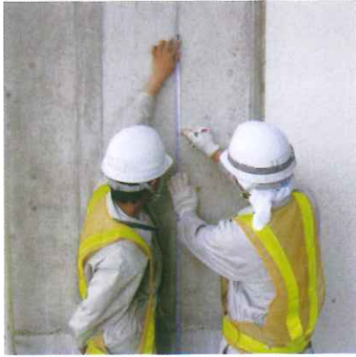
躯体実測・墨出し状況
