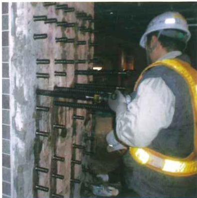
アンカー筋打設状況
