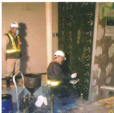
樹脂注入状況
