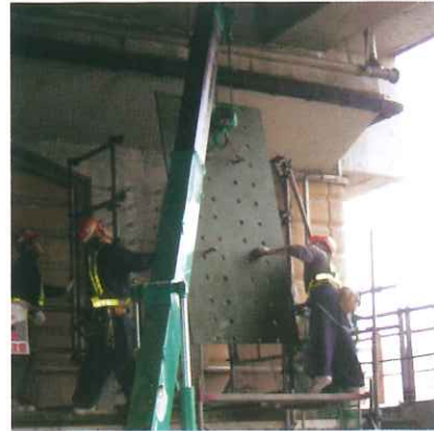
鋼板取付状況
