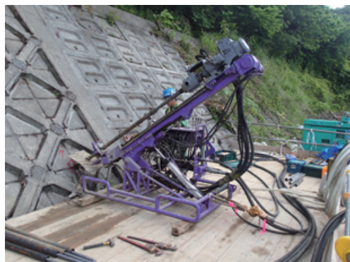
ホーク・ネイリング 試験施工状況
