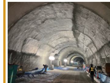
境トンネル 断面修復工事
