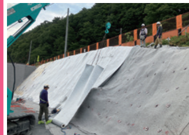
パデムシート(重金属吸着シート)施工状況
