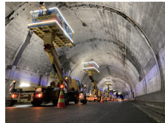
RBSフォーム工法 〈ウレタン樹脂による背面空洞充填工〉
