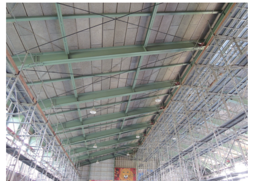
足場の設置状況（屋根、長尺配置）
