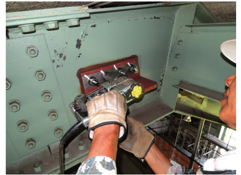
定着金具の取付（屋根）
