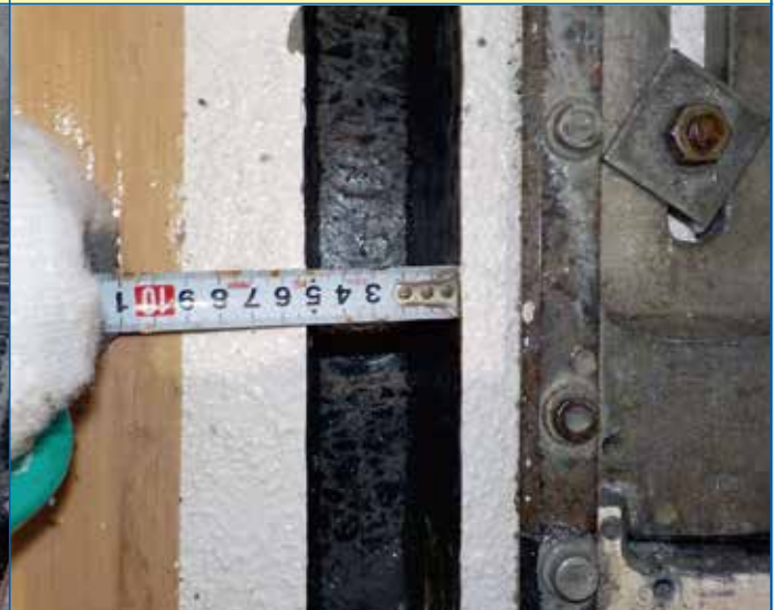
9.スリット材取付け完了
