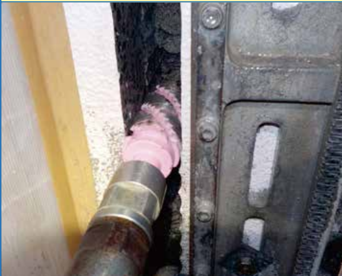
8.スリット材取付け
