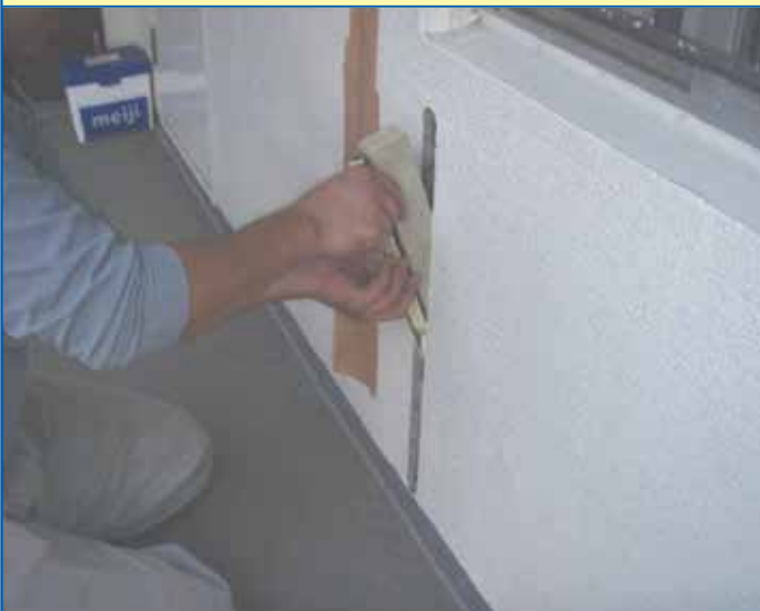
8.スリット材取付け
