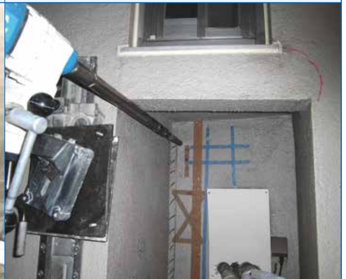
水平スリットの施工
