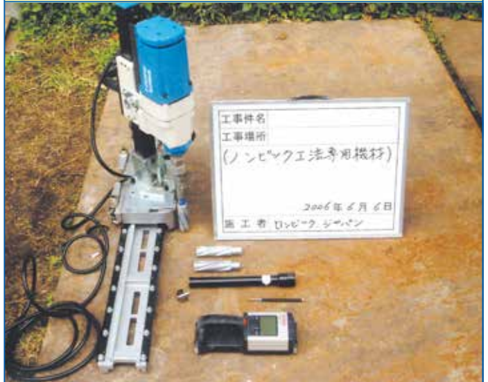
4.ガイドレールと専用切削機のセット状況
