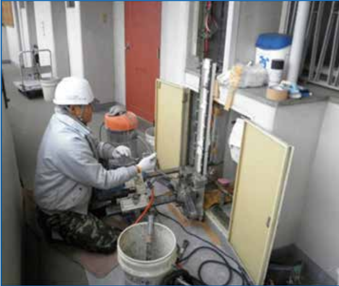
狭小機にて施工(後部作業スペースが狭い場合)
