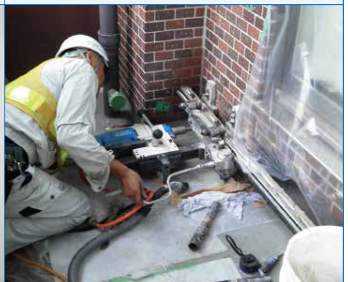
水平スリットの施工
