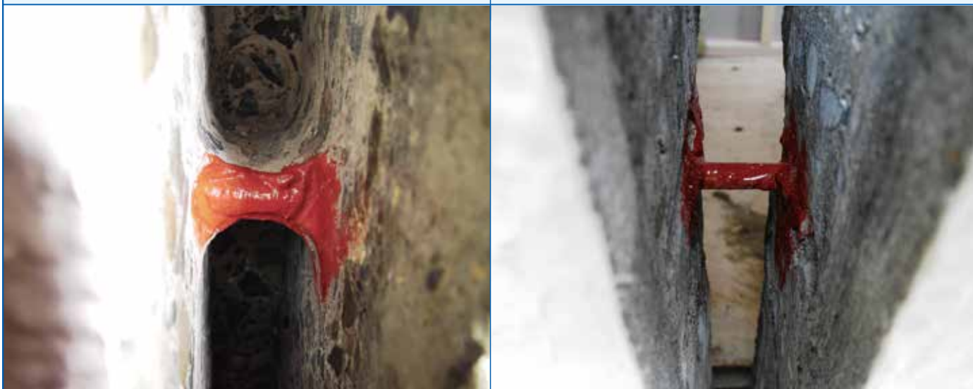
垂直部分スリット:横筋残し
