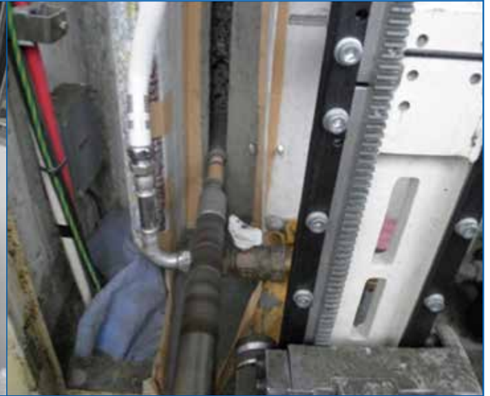
奥まった壁のスリット施工
