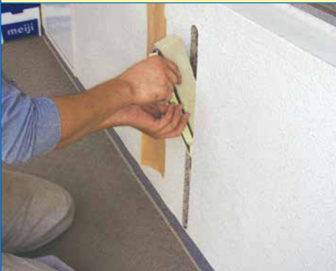
8.スリット材取付け
