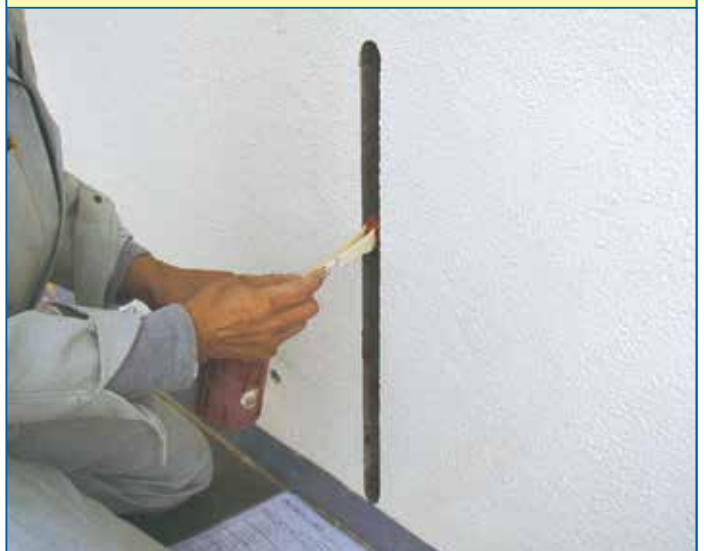
7.鉄筋錆止め処理
