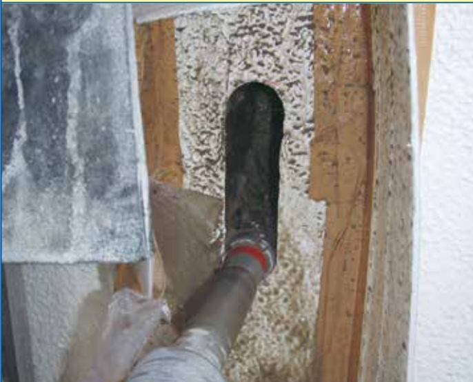
8.スリット材取付け
