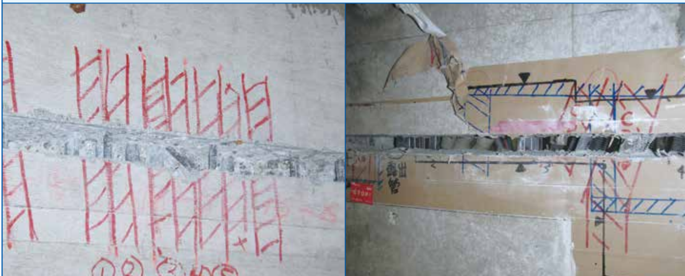
垂直部分スリット:横筋残し
