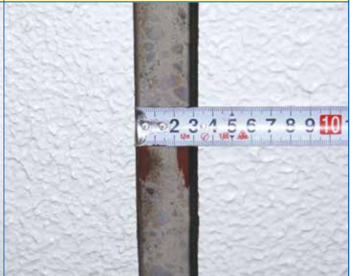
9.スリット材取付け完了
