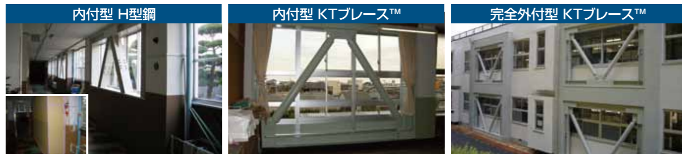
▲ 施工風景 (内部は使用しながら施工)
