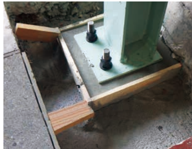
5 あと詰めモルタル注入
