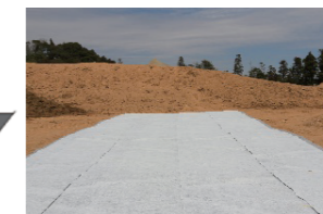
パデムシート敷設完了
