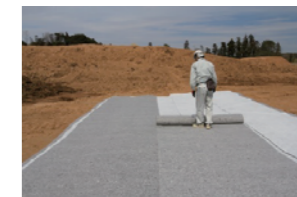
保護マットの敷設状況 (保護土との接地面側)
