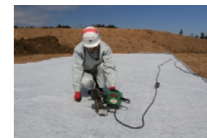
パデムシート継ぎ目溶着状況 (自動溶着機)
