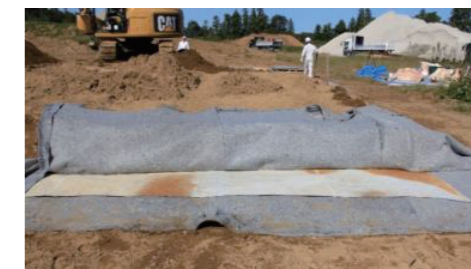
②損傷無し
