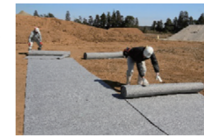
保護マットの敷設状況 (基盤面側)
