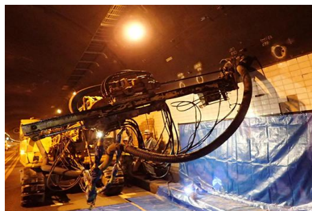
ロックボルト補強工事
