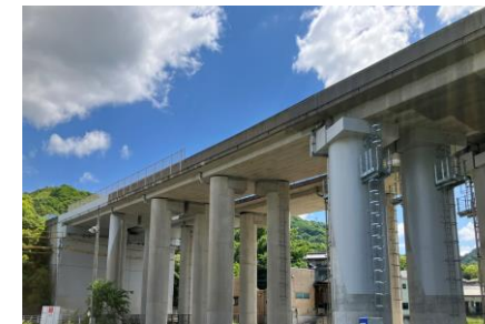
国分寺高架橋他5橋耐震補強工事
