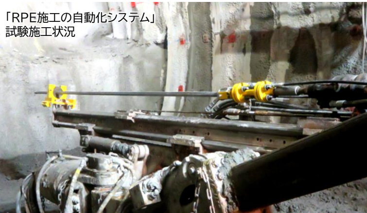
「ロックボルト自動打設用TD24繫ぎボルト」
