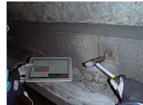
現場アンカー検査状況
