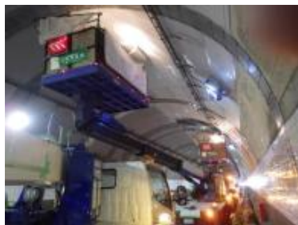
トンネル長寿命化大規模修理
