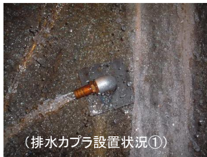
(排水ホースによる湧水の静水処理)
