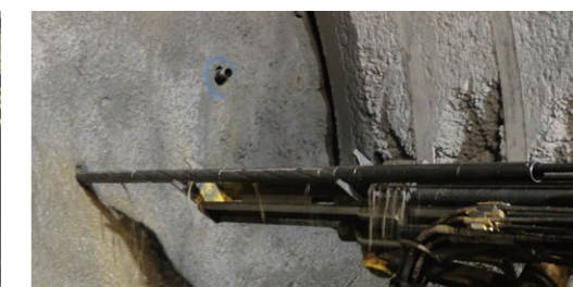
Me-fix 施工状況
