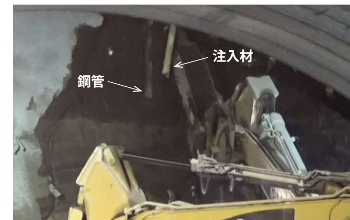
AGF-Me工法の切除状況
