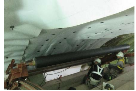
展張機を使った幅広シート施工
