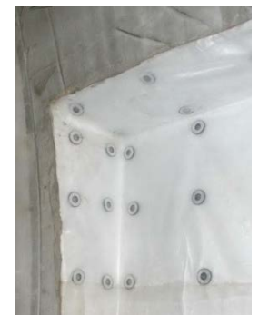
箱抜き部の固定例
