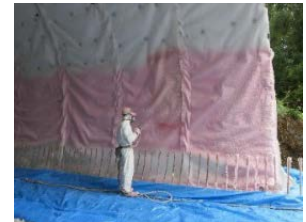
ウレタン吹付け状況
