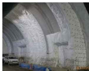
防水シートの二重貼り
