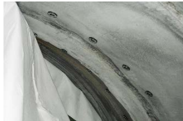
吹き付け面に固定されたカーボディスク
