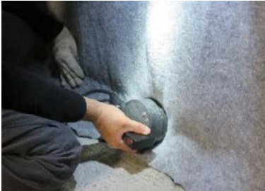
IH ウェルドによる内面保護用不織布の固定
