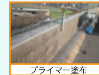
プライマー塗布
