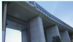
ShieM-CS 工法 施工完了
