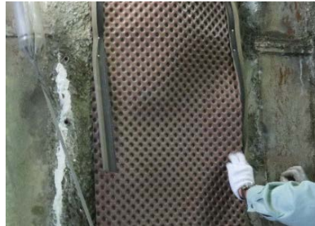
FILM 工法でのタマゴパックドレンの設置状況、周囲をシールプレートでシールして充填モルタルが流入しないようにする
