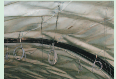
覆工天端部から取り出したコンタクトグラウトホース
