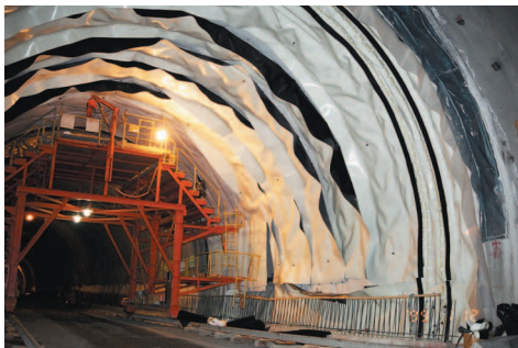
アーチ部施工
