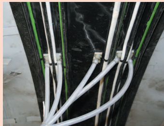
ウォーターバリアに併設のグラウトホース
