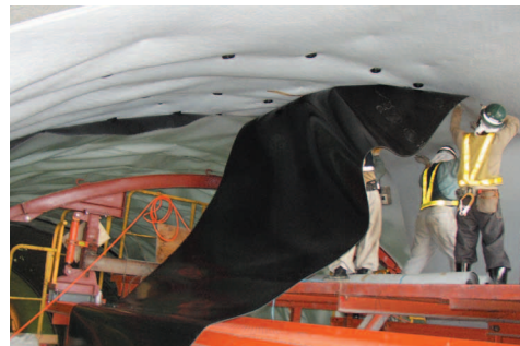
アーチ部施工
