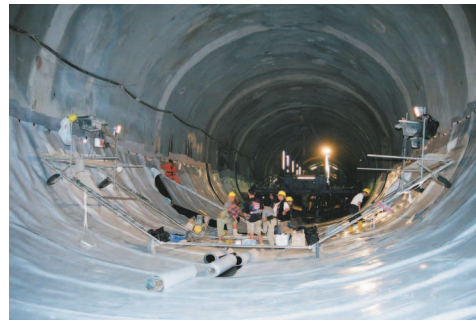
インパート部施工
