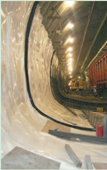
ウォーターバリアの設置
