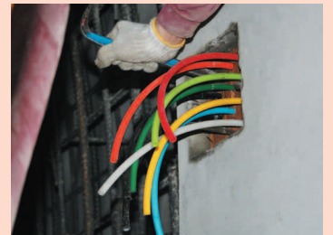
覆工から取り出された注入口(注入ホース)
