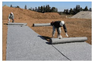
保護マットの敷設状況 (基盤面側)
