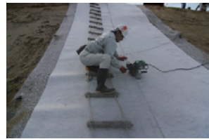
パデムシートの敷設～継ぎ目溶着状況（斜面部）
