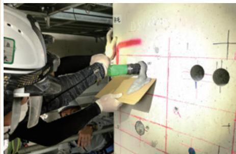
SRインジェクションカプセルを用いた鉄筋挿入状況
