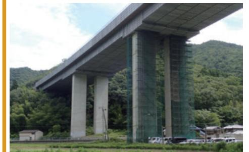
舞鶴若狭自動車道 橋梁補修工事(補修用足場設置状況)
