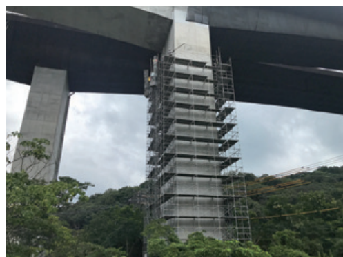
山陽自動車道 橋梁はく落対策工事(足場設置状況)
