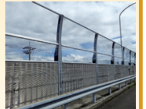
山陽自動車道 橋梁はく落対策工事(吊足場撤去状況)
