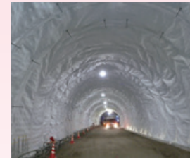
防水シート施工完了状況
