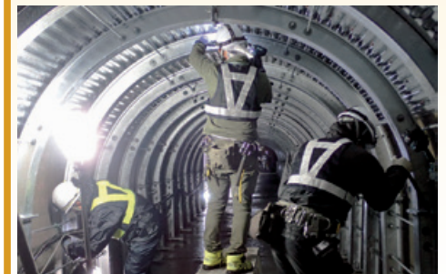
安房トンネル補修工事(支保工設置状況)
