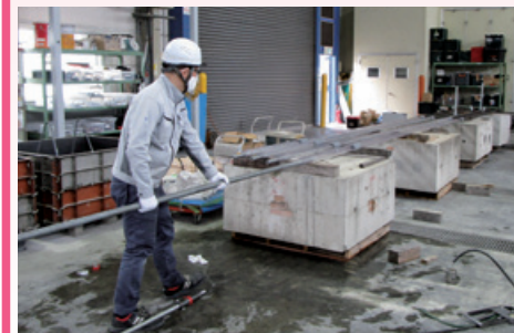
ロックボルト施工性確認試験
