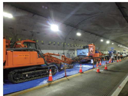
土洲トンネル ロックボルトによるトンネル補修工事
