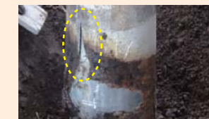
② 破口を起点に亀裂発生 (拘束治具なし)
