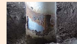
① GPR 鋼管挿入
