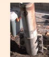
② 拘束治具設置
