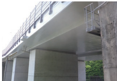
ShieM-CS工法 施工完了
