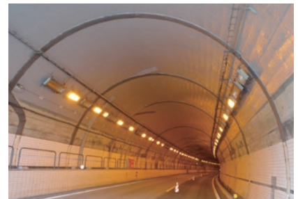
ShieM-CS(TN)工法 施工完了
