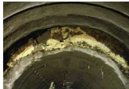
空洞充填状況
