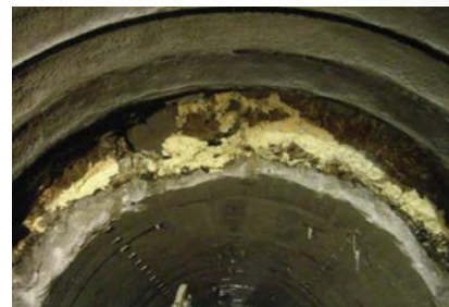
空洞充填状況
