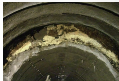
空洞充填状況
