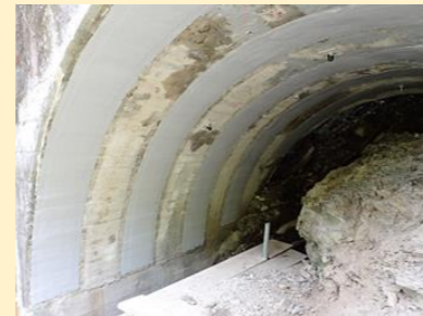
⑥施工完了
