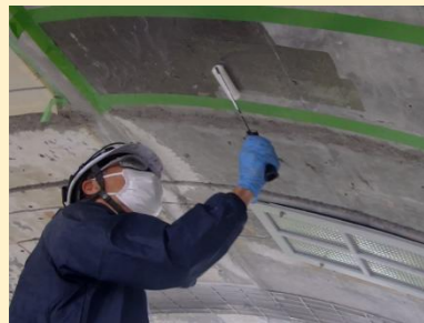
①プライマー塗布
