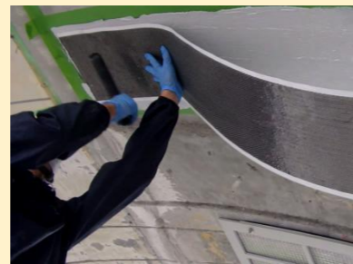
③SHシート貼付
