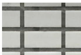
※目視点検用スリット
