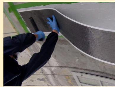
③SHシート貼付
