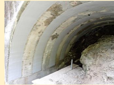
⑥施工完了
