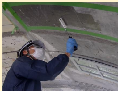
①プライマー塗布
