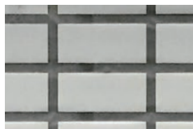
※目視点検用スリット
