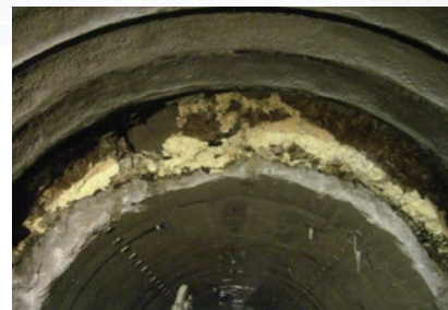
空洞充填状況
