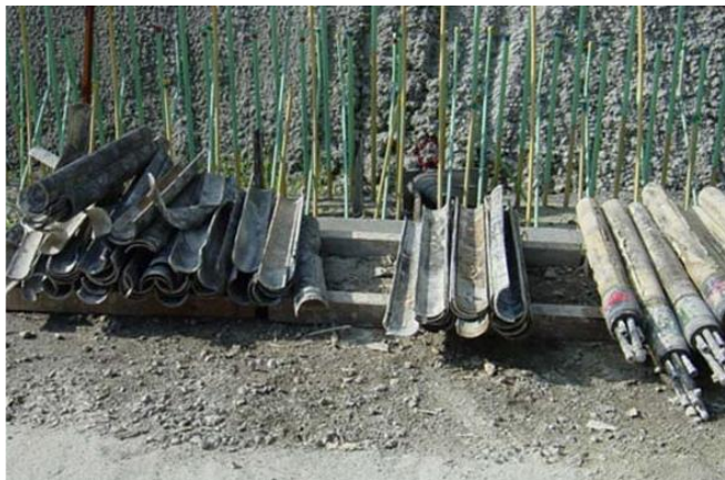
(端末鋼管・注入材分別状況)
