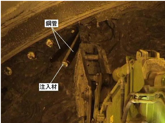
(端末鋼管切除状況)
