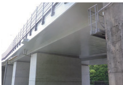
ShieM-CS工法 施工完了
