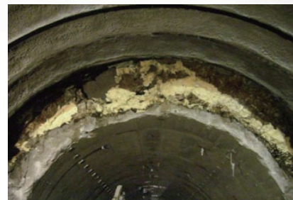
空洞充填状況
