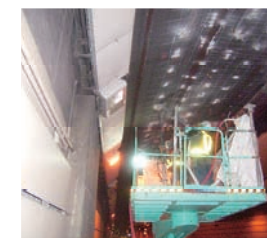
●トンネル・共同溝
